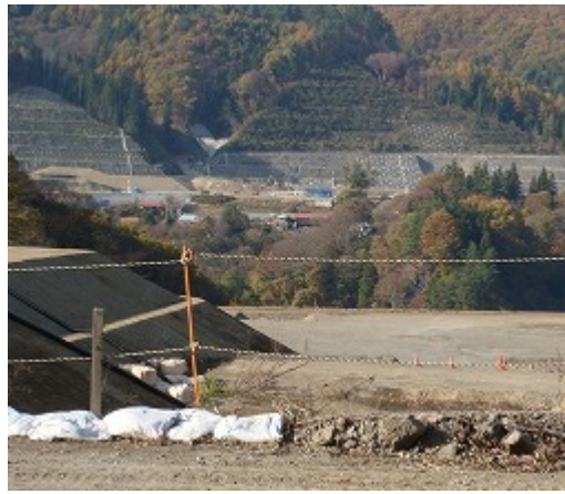
付け替え道路、代替住宅地用に山が削られています
