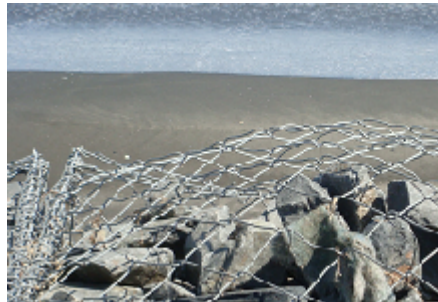
3月18日の様子: 津波の力でジャカゴの中の岩が動き、鉄線のジャカゴが波打っています
