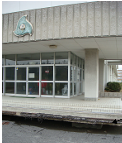
海面埋め立て事業で造成された土地に 1984 年に創立した。以前から地盤沈下があり、補修されていた。
